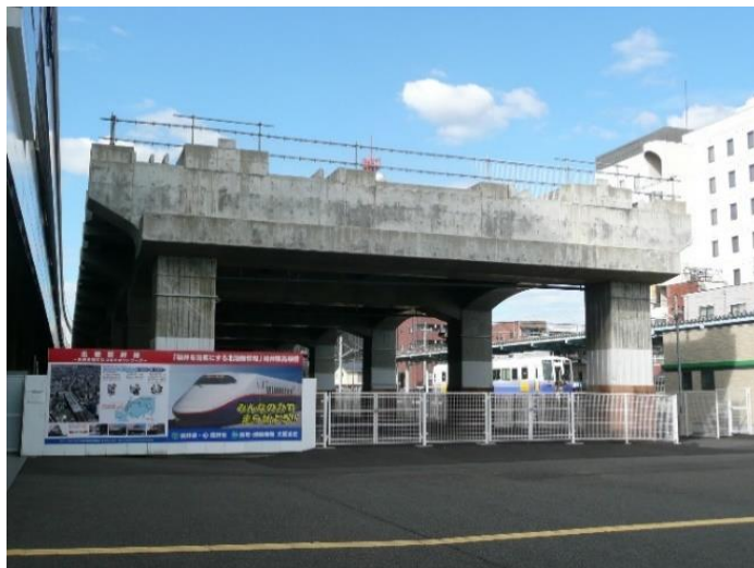
《図表2》 北陸新幹線福井駅の先行工事の様子
